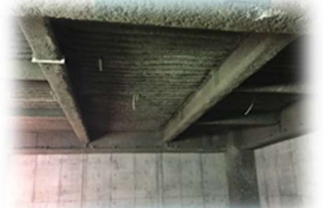
▲長久手市ショッピングセンター耐火被覆工事
